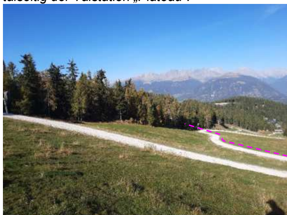
Foto 9: Verlauf der Füll- und Entnahmeleitung im Bereich der Piste „Alpen“.
