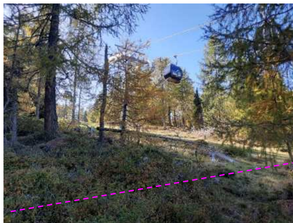
Foto 8: Verlauf der Füll- und Entnahmeleitung bei der Querung „Lorenzlift“.
