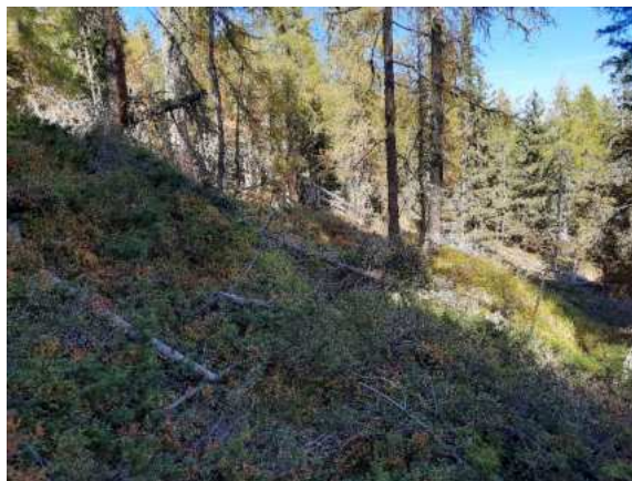
Foto 20: Abbruchkante der komplexen Massenbewegung. Sämtliche Bäume zeigen einen deutlichen Säbelwuchs auf.
