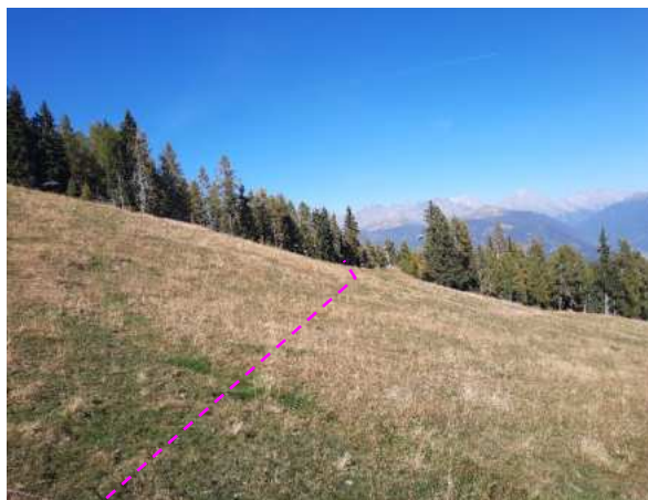
Foto 7: Verlauf der Füll- und Entnahmeleitung talseitig der Talstation „Plateau“.
