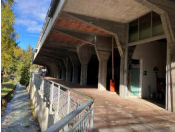
Fig. 6 – Talstation beidseitig des Gröden Bachs / stazione di valle su entrambi i lati del Rio Gardena
