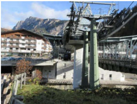
Fig. 2 - Bereich der Talstation / area stazione di valle
